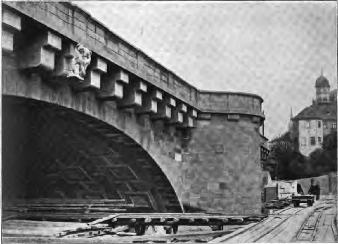
Abb. 61. Bogenleibung der neuen Augustusbrücke in Dresden. Arch. Prof. Kreis.
